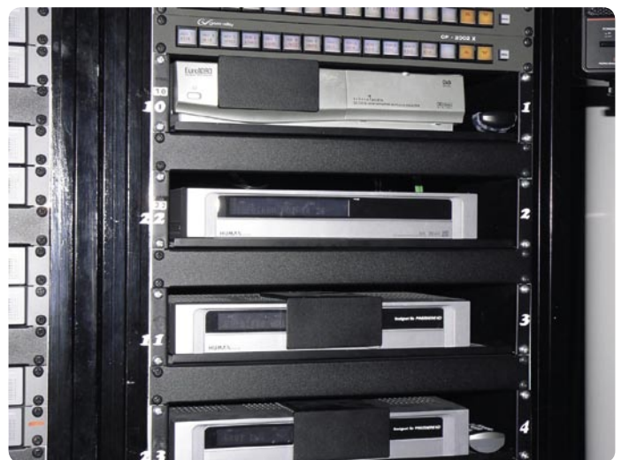
▲ Yayın sinyali Humax gibi üreticilerin standart HDTV alıcılarıyla kontrol ediliyor
