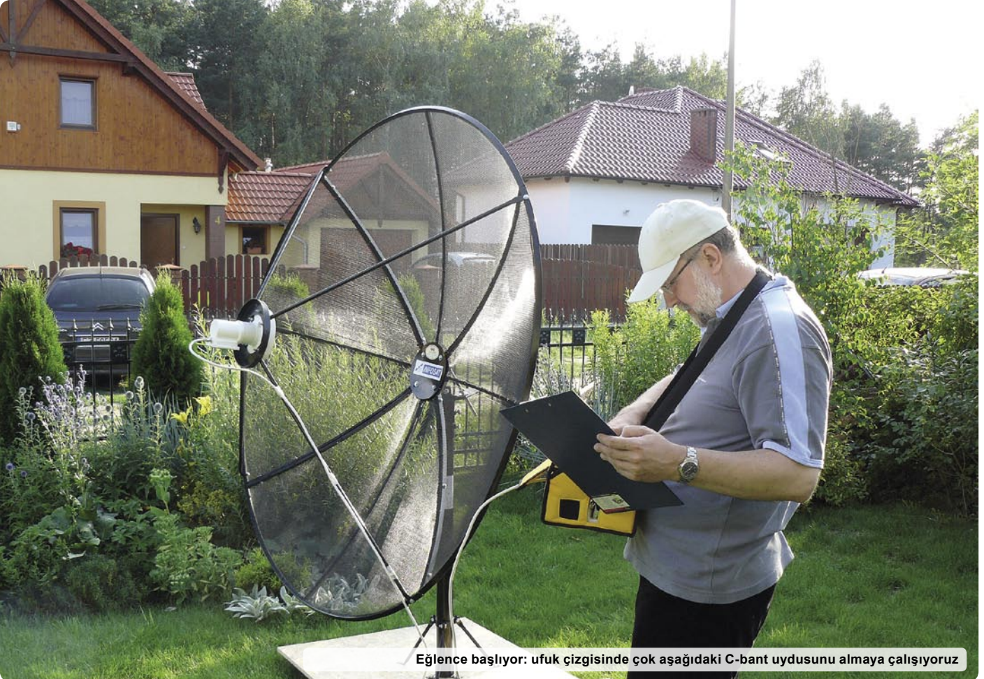
Anteni ayarlama zamanı. Açık ölçekli bir terazi tavsiye ederiz. Böylece elevasyonu çok daha kolay ayarlayabilirsiniz.
