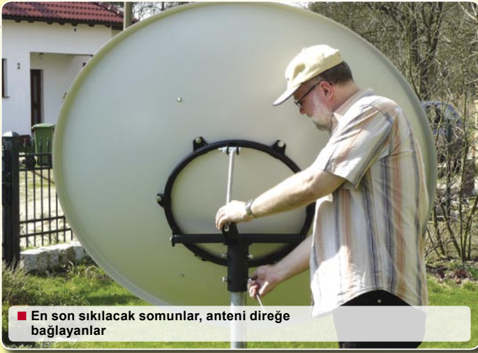
■ Elimin altındaki bir LNB'yi kullandığım için antenin kendi feedhornu ve desteğine ihtiyaç duymadım
