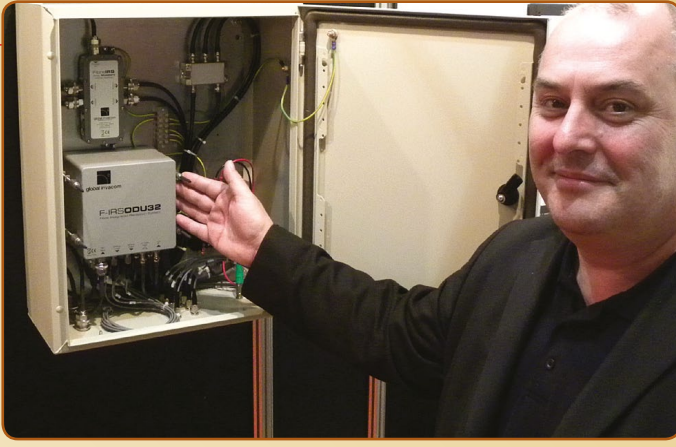
■ GlobalInvacom'da bir yenilik. Dört ODU32 bileşeni bir arada sekiz özdeş optik bağlantı sağlıyor. Bunlar 256 nokta besleme kapasitesinde.
